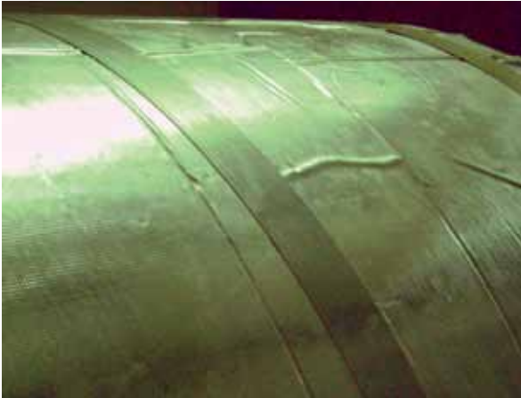
Рисунок 4. Изменения геометрических размеров скорлуп на НВТС
